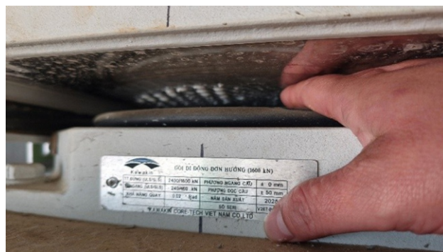
Hình 3. Một số hình ảnh về hiện trạng gối cầu của kết cấu nhịp cầu thép bị hỏng do lỗi thi công
