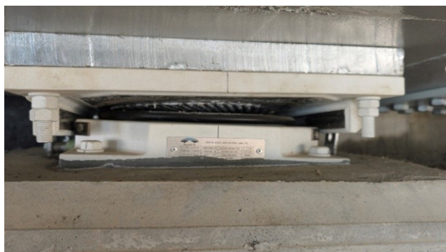
Hình 3. Một số hình ảnh về hiện trạng gối cầu của kết cấu nhịp cầu thép bị hỏng do lỗi thi công
