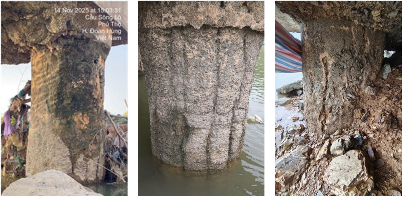
Hình 2. Hiện trạng hư hỏng một số cọc khoan nhồi tại cầu Sông Lô
